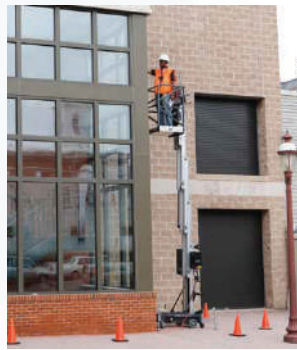
การซ่อมบำรุงภายนอกอาคาร
